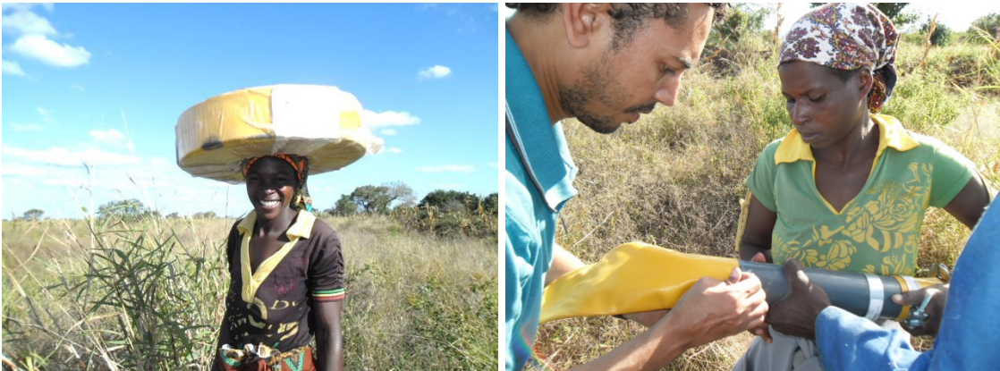
Imagens 31, 32, 33, 34, 35 36 e 37 – (Da esquerda para a direita e de cima para baixo) Entregas do dia 7 de Maio: Demonstração da colocação dos segmentos de copolene e abraçadeiras nas ligações – Tinonganine; Momento de analisar opções: a avaria da moto-bomba da medida da tubagem adquirida para Tinonganine, obriga a utilizar tubagem intermediária redutora de 10 para 7,5 cm entre o primeiro segmento de 50 m de mangueira e a moto-bomba, para que se possa usar a moto-bomba que está no momento operacional e o equipamento oferecido - Tinonganine; Ida até ao ponto de tomada de água (posição da moto-bomba) e ponderação de opções para superar a distância de cerca de 600 m até à machamba - Manhangane; Recorremos à tubagem em copolene em uso na Associação e na fotografia estamos em deslocação até ao ponto de ligação do primeiro segmento - Manhangane; Primeira ligação - Manhangane; Transporte de uma bobine até ao ponto de ligação - Manhangane; Trabalho de equipa na ligação de dois segmentos - Manhangane.
