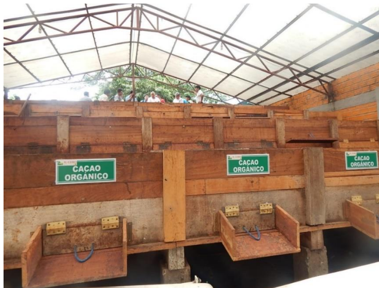
Foto N° 23: Secadores Planta del CEIBO
