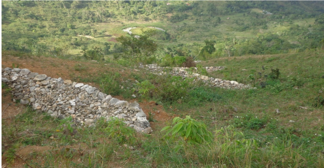
Photo I Activités de conservation de sol pour la protection du bassin versant alimentant l'étang de Margon
