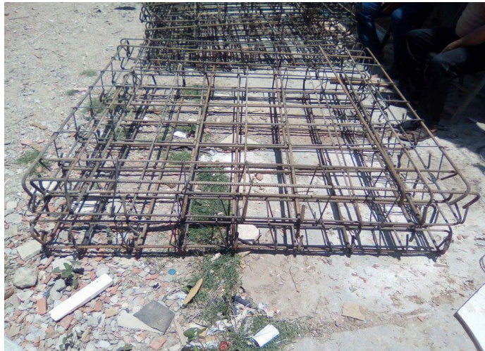
Figure 19 : Le ferrailage du corps mort
