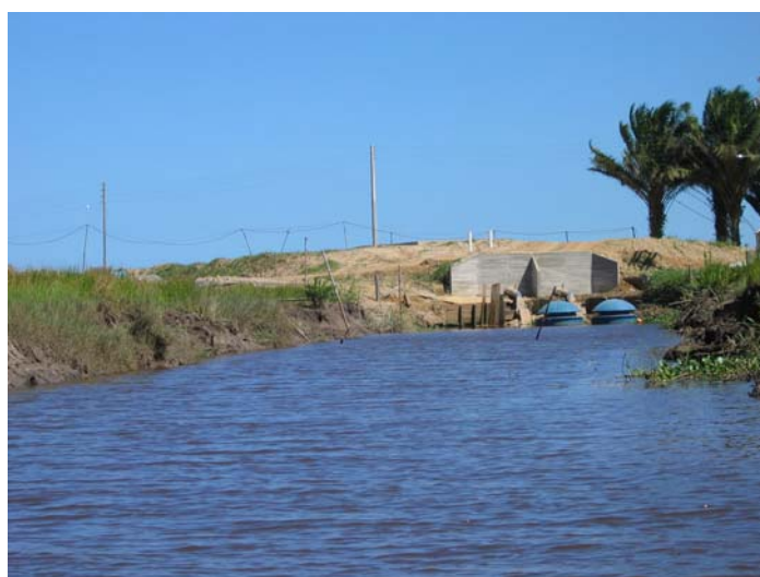
Figura 63 – Apicum impactado por captação de água de fazenda de carcinicultura no Rio Parco, em Canavieiras, 2006.
