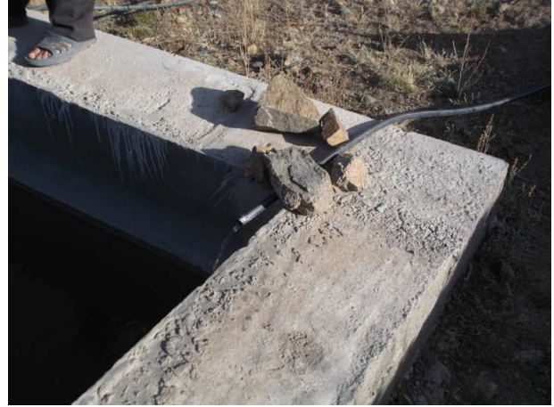
Photo 2 : Conduite d'alimentation à partir du talweg adjacent à la pépinière
