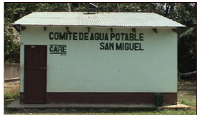
Potabilización del agua en San Miguel del Bala.
