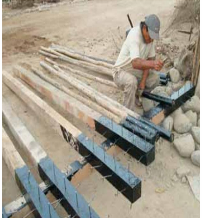
Columnas tratadas con la solución mencionada
