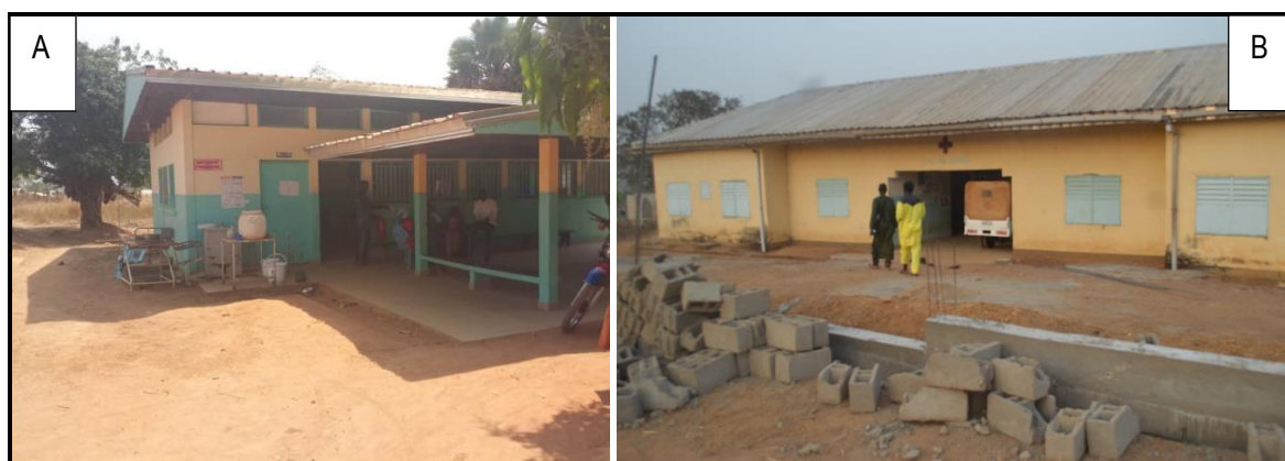
Photo 14 : Centre de santé intégré de Sambolabo (A) et de Dodéo (B)
